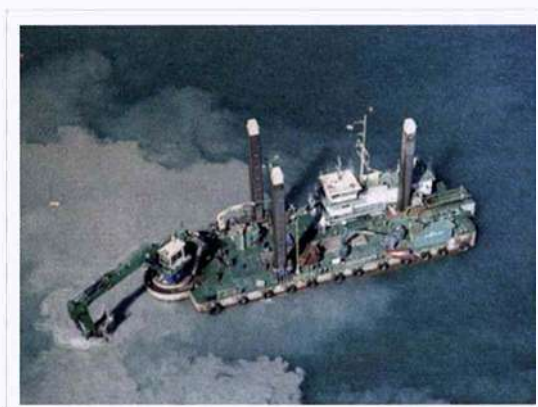
Figura II-22 · Materiais em suspensão associados às operações de dragagem
