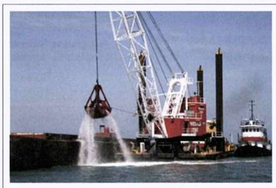
Figura II-17 - Dragagem com draga de caçamba.
