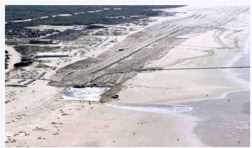
Figura V-16 Alimentação das praias da Costa da Caparica. Extremidade do pipeline de repulsão e trabalhos de reperfilamento na praia.
