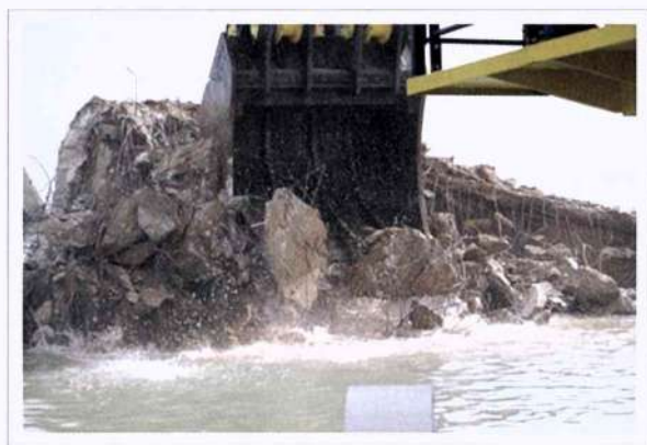
Figura II-16 - Draga escavadora a retirar material acima do nível de água.
