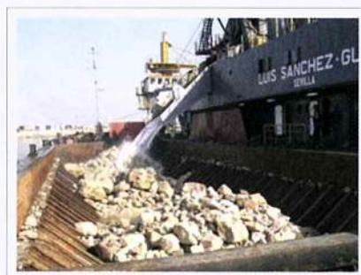
Figura II-7 - Depósito de materiais no batelão com draga de alcatruzes.
