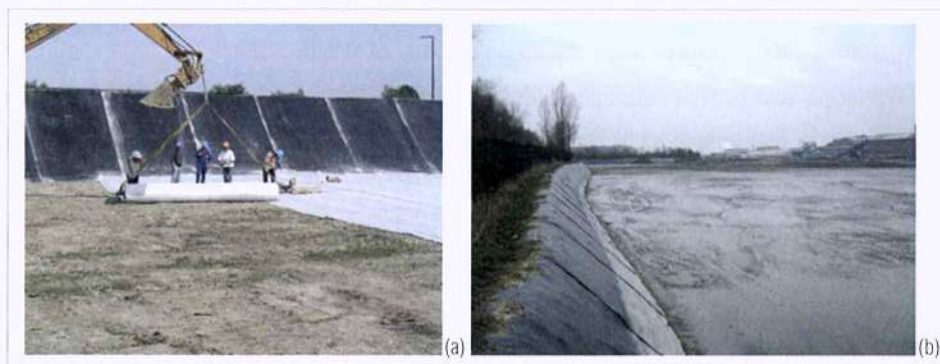
Figura I-17 - Depósito em terra construído no Douai (localidade do Norte da França) de aproximadamente 80000\text{m}^3 (a) ainda em fase de construção; (b) posterior à entrada em serviço.
